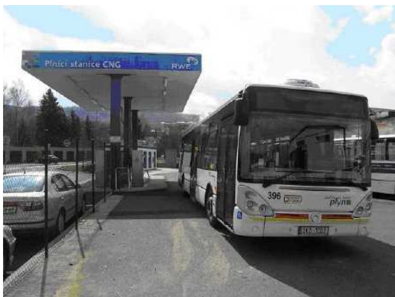
Obr.: Obrázek PS CNG v Karlových Varech
