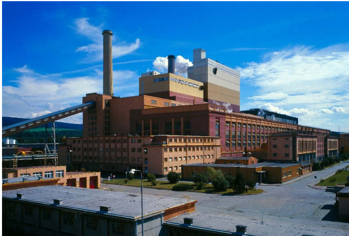
Obrázek 8 Pohled na Elektrárnu Tisová
