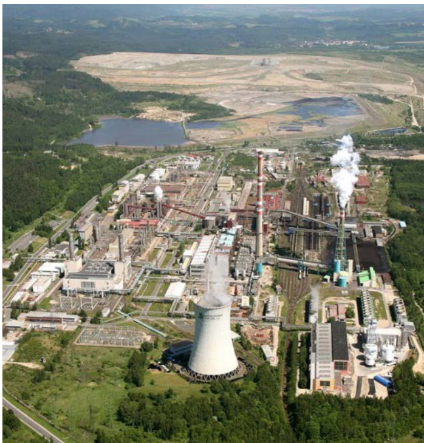
Obrázek 10 Pohled na Elektrárnu Vřesová
