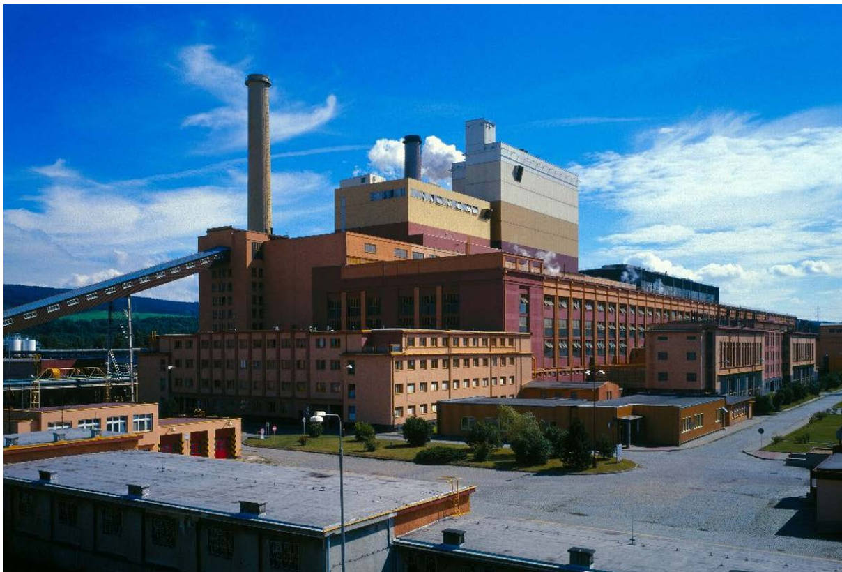
Obrázek 8 Pohled na Elektrárnu Tisová
