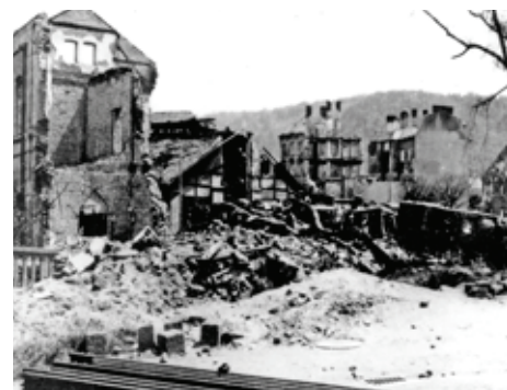
Budova rotundy depa a dílen po ničivém náletu
