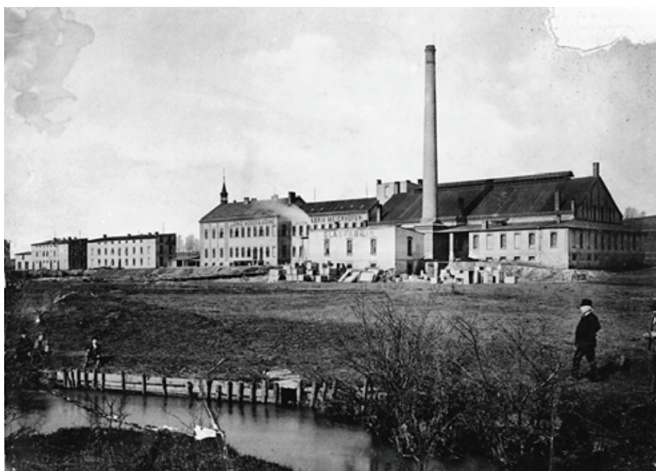
Sklárna Moser v roce 1892
