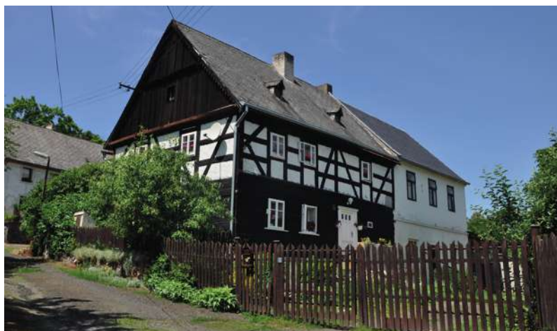
Dům ev. č. 15 v Zámecké ulici
