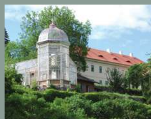
Palmový skleník a budova správy zámku
