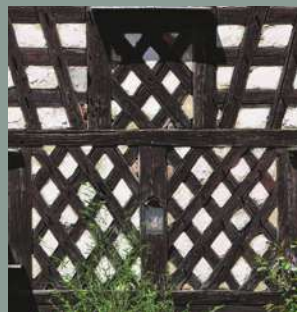
Hrázděná konstrukce čp. 50
