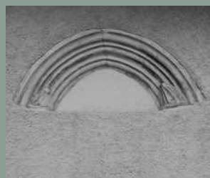
Zbytek sedátkového portálu v ohradní zdi fary
